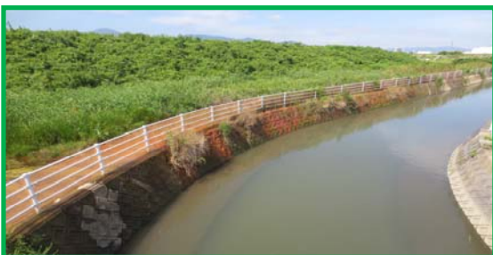
曾根豊岡緑地施工前
