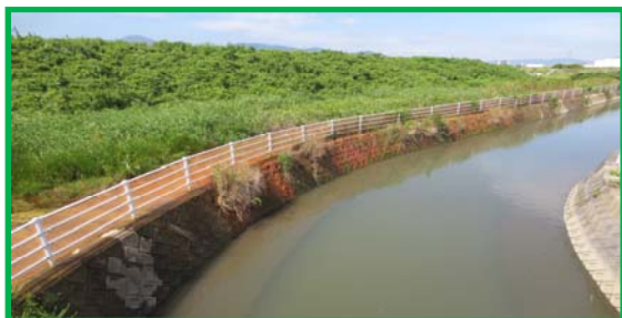
曾根豊岡緑地施工前
